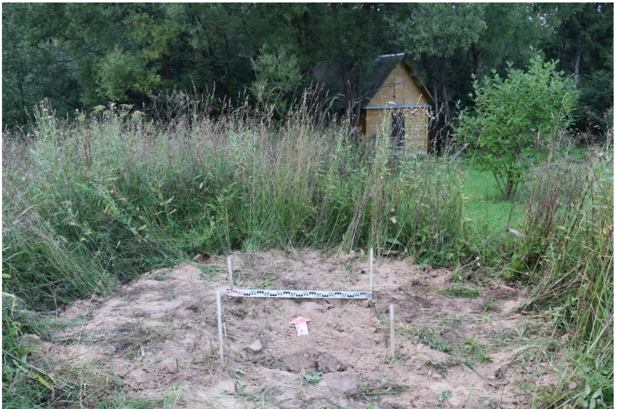
Рис. 27. Археологическое обследование участка по объекту: «Уличные газопроводы дер. Бардино Юхновского района Калужской области». 2023 г. Шурф 2. Рекультивация. Вид с Ю.
